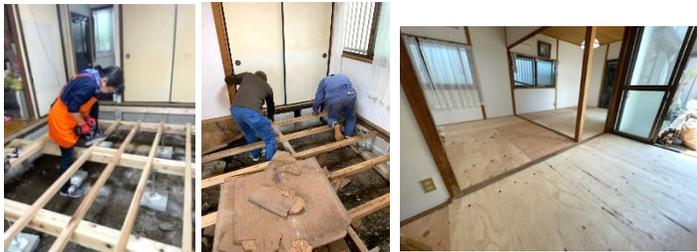
床ができたところでエアコン室内機の取外しや照明器具を取外します。これもスキルアップ講習の一部です。天井はビニールクロス、壁は漆喰塗りにする予定ですが、天井の雨染みが気になります…。4mのビニールクロスは糊付けされると重くなり、作業者を悩ませます。「イナハウアー」の姿勢での天井クロス貼りは首が痛くなりました。次は壁に漆喰を塗ります。今回は溶かさずにそのまま塗れる漆喰を用意しました。昨年開催したスキルアップ講習では壁模型を使用しましたが、本物の壁に塗るのは初めての経験です。既存の壁紙は剥がさず、予めアク止め効果のある定着材(シーラー)処理をした上に2回塗りで仕上げ、母屋との接続部分の壁には雨漏り点検用の点検口を設けました。
