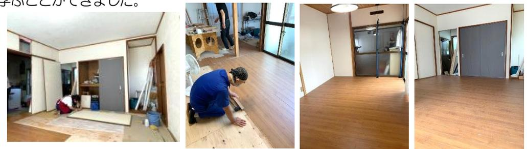
床貼りの合間には襖を洋風に変えました。濃いグレーのビニールクロスをポイントに据え、母屋との接続部の襖を含む3枚はM様が取り寄せたウィリアムモリスの壁紙を貼り、こだわりの空間を演出します。しかしここから想定外の事態が発生。屋根の雨漏り箇所と思われる場所をコーキング材で補修しようと屋根に上がったところ、靴が沈んでしまう程ベコベコ。結果雨漏りを助長することになってしまいました。大雨警報が発出された豪雨の日、天井や壁が
